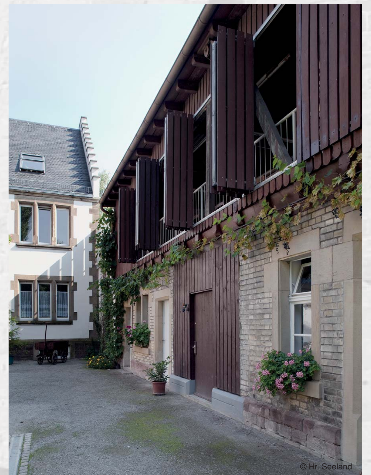
Ökonomiegebäude : Fassade geöffnet
