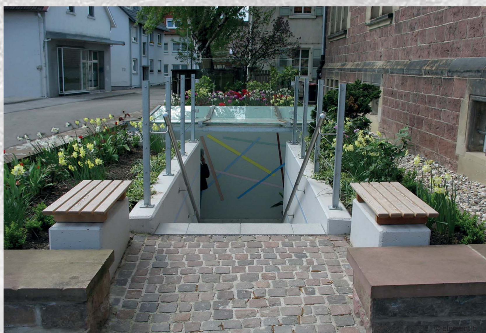
Zugang zum Untergeschoß
